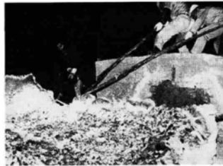
炉を崩して精鋼（錐）をとりだす
