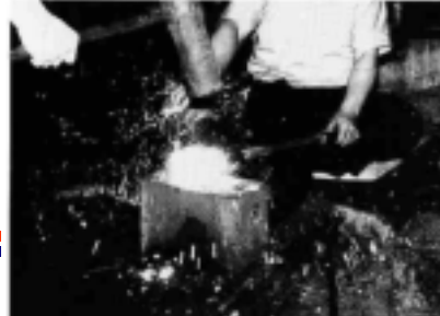
湯かされた鋼を大釜で叩く
